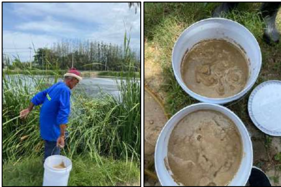
รูปที่ 2-9 การเติมจุลินทรีย์ในบ่อบำบัดน้ำเสีย
