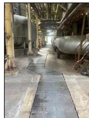
รางรวบรวมน้ำฝนปนเปื้อน
